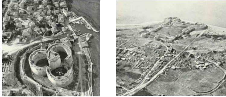
Şekil 7: (Sol) Çanakkale, Kilitbahir Kalesi (Williams, 1928)
