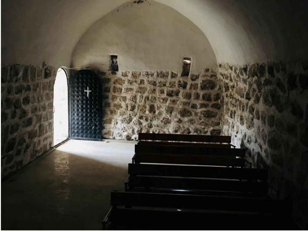
Fotoğraf 5. Mor Muş Kilisesi iç mekan doğudan görünümü ve üst örtüsü.
