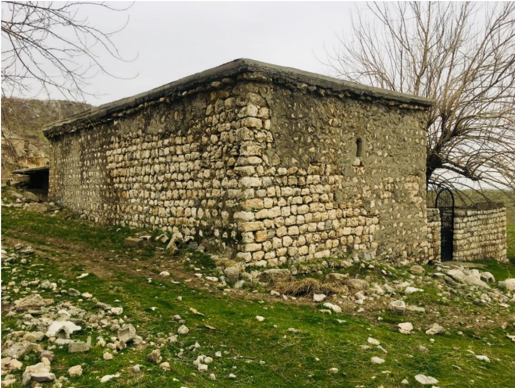
Fotoğraf 8. Evengeleta Kilisesi kuzeybatı cephesi görünümü.
