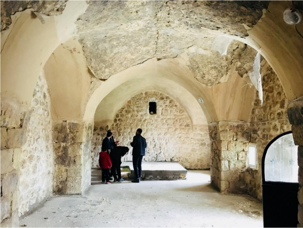
Fotoğraf 10. Evangeleta Kilisesi İç mekan batıdan genel görünüm.
