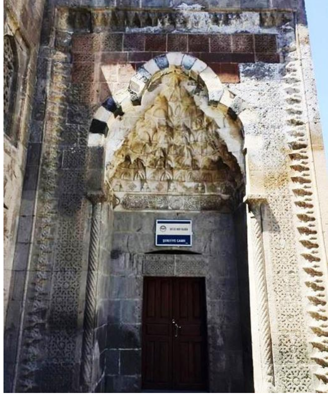
Fotoğraf 50: Bitlis Şerefiye Külliyesi taçkapısı
